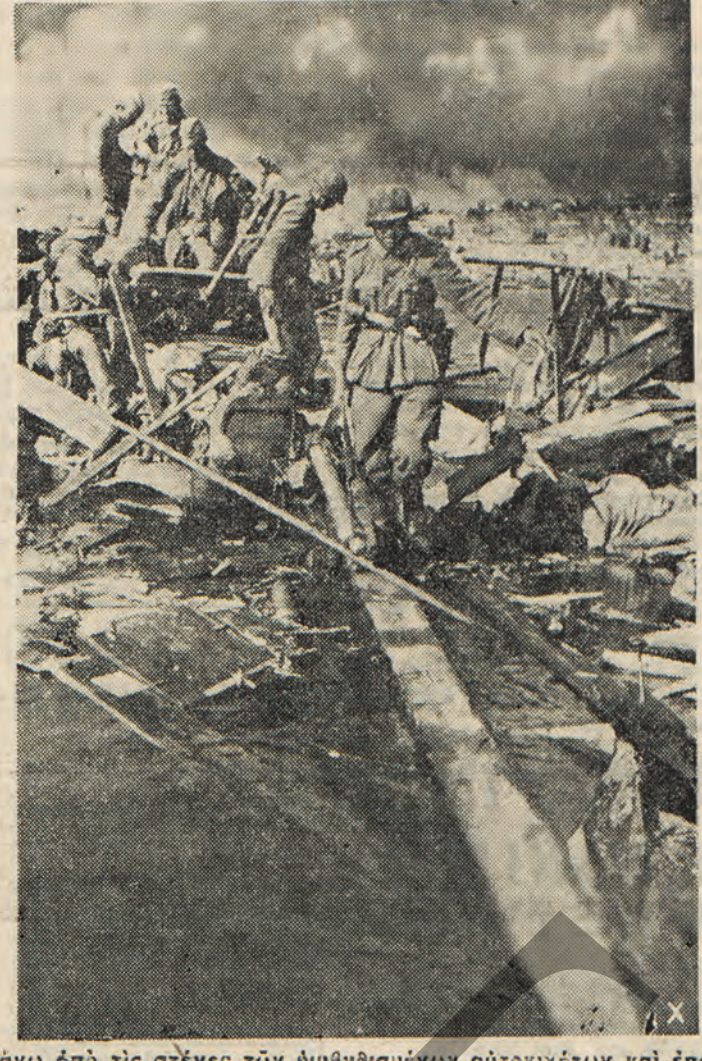
Ένα από τις στήγες τών ήμισυθισμένων αυτοκινήτων και επάνω από κιάτια πυρομαχικών έχει κατασκευασθεί νέα γέφυρα τού Δούβ 3-4 μέτρα επάνω εις παλιάν που εβυδίαθη.
