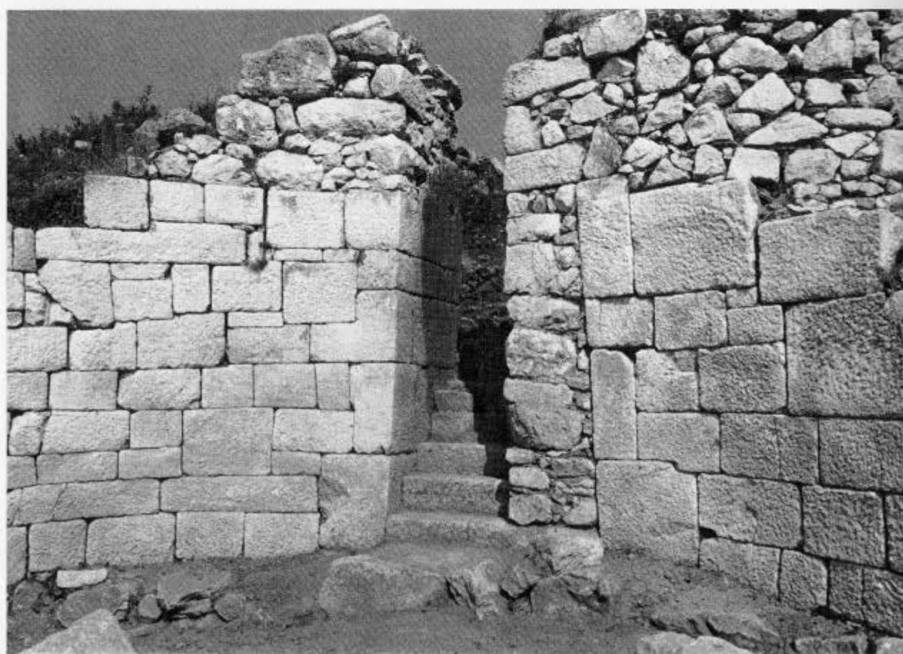
3. Το αναλημματικό κρηπίδωμα στη ΒΔ γωνία του φρουρίου. 4. Εσωτερικό και πύλη ΝΔ κυκλικού πύργου.
