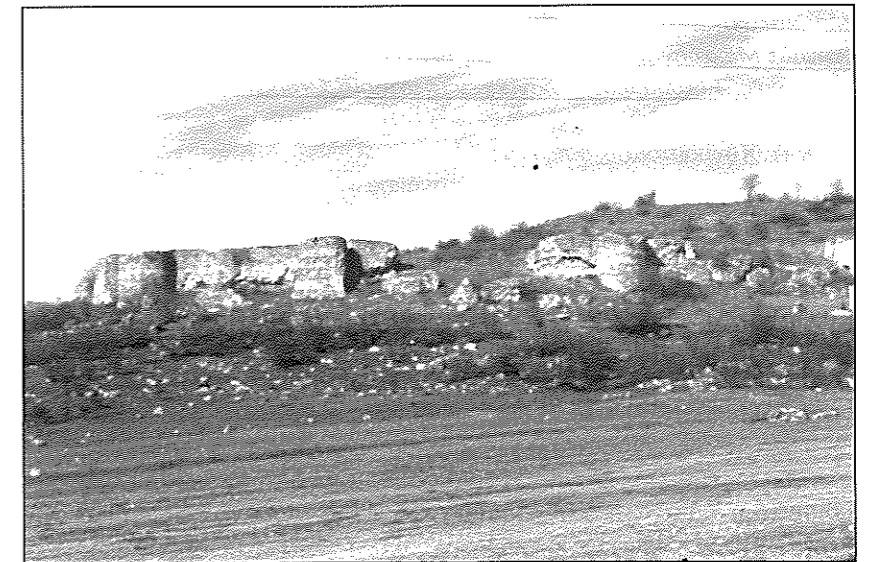
Εικ. 10. Χρυσή Αλμωπίας. Άποψη του μεσοβυζαντινού κάστρου.
