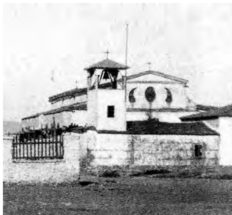
Εικ. 11. Η νοτιοανατολική πλευρά της βασιλικής του Αγίου Αχιλλίου με το χαρακτηριστικό σύμπλεγμα των τριών παραθύρων κάτω από το αέτωμα. Φωτογραφία του 1890 περίπου.
