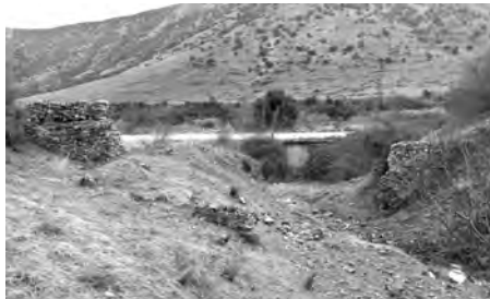
Εικ. 9. Φωτογραφία τών έρειπίων τών 2 παραλλήλων γεφυρών του ύδραγωγείου
