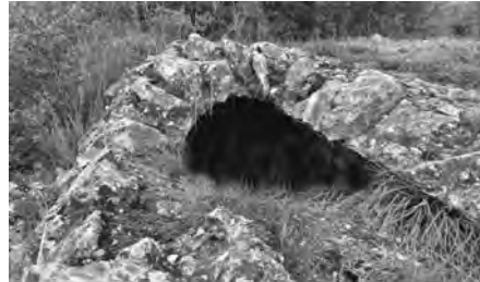
Εικ. 6. Ὁ υπόγειος κτιστός ἀγωγός του ύδραγωγείου.
