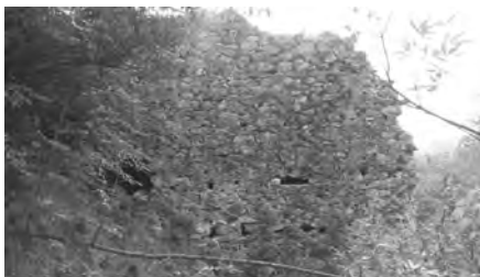
Εικ. 1. Ο τοίχος της ύδραγωγού γέφυρας.
