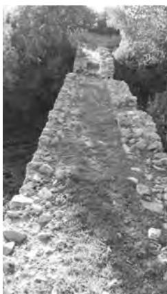
Εικ. 3. Τό κτιστό κανάλι του ύδραγωγού.
