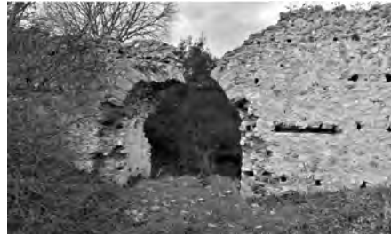
Εικ. 5. Τό τόξο τῆς Β΄ γέφυρας του ύδραγωγείου.
