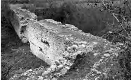
Εικ. 4. Η Β΄ ύδραγωγός γέφυρα του ύδραγωγείου.
