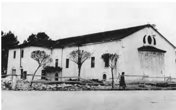
Εικ. 5. Ὁ Ἱερός Ναός τοῦ Ἁγίου Νικολάου λίγο πρὶν τὴν κατεδάφισί του.
