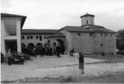
Εικ. 1. Τό καθολικό τῆς Ἱερᾶς Μονῆς τοῦ Ἁγίου Νικολάου Σιαμάδων νοτιοδυτικά με τό σύγχρονο εὐρύχωρο κτίριο (19.5.2016).
