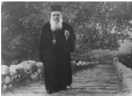
Γέφυρα Αγίου Βησσαρίωνος, Πύλη Τρικάλων, 1966.
