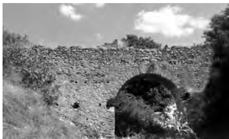
Είκ. 11. Η άκερμα υδραγωγός γέφυρα.
