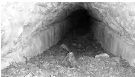
Εικ. 7. Τό έσωτερικό του κτιστού άγωγού.
