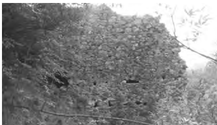
Εικ. 1. Ο τοίχος της ύδραγωγού γέφυρας.
