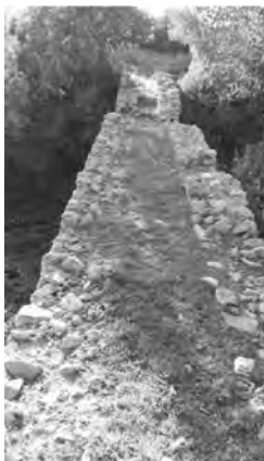
Εικ. 3. Τό κτιστό κανάλι του ύδραγωγού.
