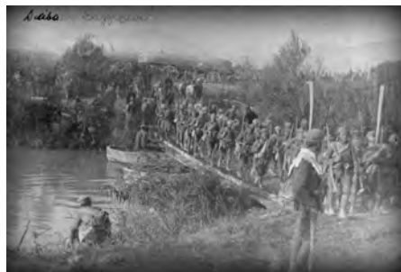
Φωτ. 7, 8. Λεμφοζευκτες Γέφυρες τοῦ Λόχου Σκαπανέων.
