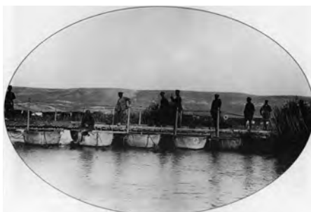
Φωτ. 7, 8. Λεμφοζευκτες Γέφυρες τοῦ Λόχου Σκαπανέων.
