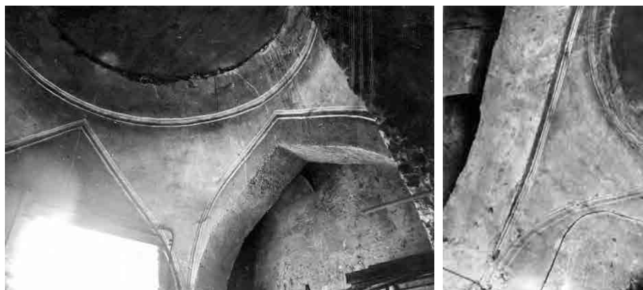
Εικ. 48, 49. Φωτογραφίες αρχείου του M. Kiel από το 1974 (Πηγή: Αρχείο M. Kiel, με κωδικό XXXIX-43 και XXXIX-44, ό.π.) Στην αριστερή φωτογραφία αποτυπώνονται τα οξυκόρυφα τόξα από τον διπλό χώρο του χλιαρού τμήματος (soğukluk) στο ανδρικό (δυτικό) τμήμα. Το δεξί οξυκόρυφο άνοιγμα ένωσε τον κεντρικό χώρο με τον μικρό επιμήκη ορθογώνιο παράπλευρο χώρο του χλιαρού τμήματος, που στεγαζόταν με τρεις μικρούς θόλους σε παράταξη (διακρίνονται ευκρινώς στην κάτοψη του M. Kiel). Το αριστερό άνοιγμα που λούζεται στο φως δεν υπήρχε στην αρχική μορφή, αλλά διανοίχθηκε αργότερα για τη λειτουργία του συνεργείου. Στη δεξιά φωτογραφία αποτυπώνονται το οξυκόρυφο τόξο (ανάμεσα στον κεντρικό χώρο του χλιαρού τμήματος και το μακρόστενο δεύτερο χώρο του χλιαρού τμήματος) και αμυδρά (δεξιά) ο θόλος του κεντρικού χώρου του χλιαρού τμήματος.
