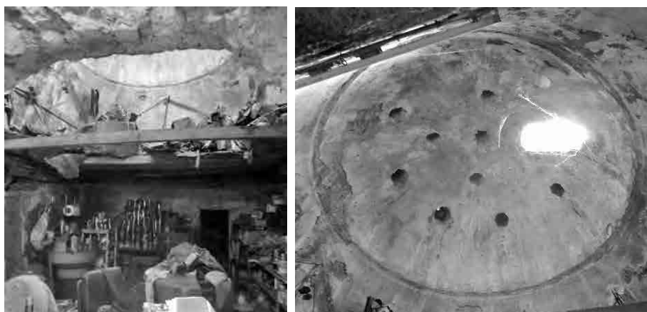
Εικ. 56, 57. Η αριστερή φωτογραφία αποτυπώνει το θερμό χώρο στο γυναικείο τμήμα του χαμάμι. Στο επάνω τμήμα της φωτογραφίας διακρίνεται η βάση του θόλου. Στη δεξιά φωτογραφία αποτυπώνεται ο θόλος του θερμού αυτού χώρου, όπου διακρίνεται η αστεροειδής διάταξη των φωτιστικών οπών, διάταξη που αποτυπώνεται και στην κάτοψη του M. Kiel (φωτ.τ.σ., 2017).
