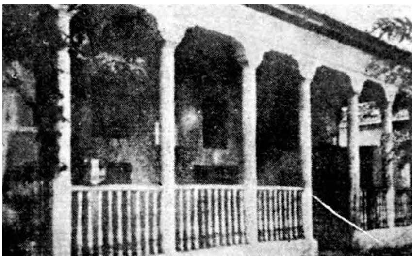
Εικ. 26. Πρόσοψη του Εσκή τζαμί με τη χαρακτηριστική κιονοστοιχία του προστώου. Διακρίνεται η κεντρική είσοδος, η κλασική πλευρική διαμόρφωση των παραθύρων εκατέρωθεν της εισόδου, καθώς και μία πάνω ζώνη παραθύρων (Πηγή: Άννα Τολούδη, Σιντική - Ιστορία και παραδόσεις, Σέρρες, 1983, παράρτημα φωτογραφιών).
