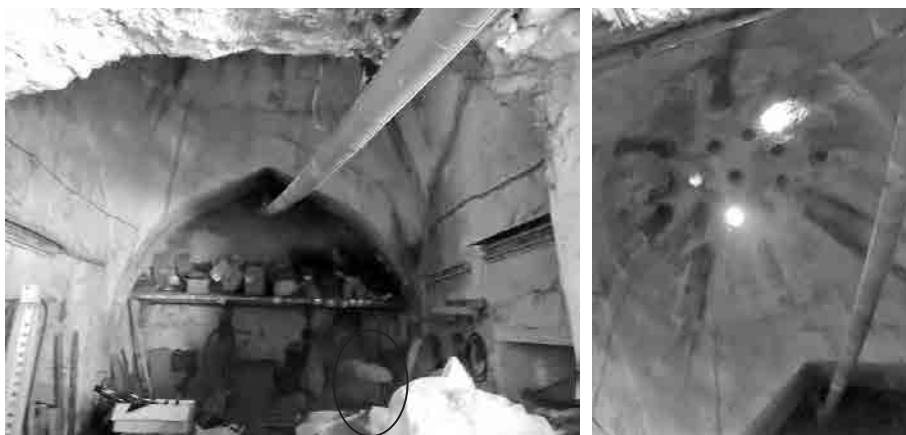
Εικ. 54, 55. Η αριστερή φωτογραφία αποτυπώνει το χώρο του χλιαρού τμήματος στο γυναικείο τμήμα (ανατολικό) του χαμάμι. Το οξυκόρυφο τοξωτό άνοιγμα που διακρίνεται ένωνε τον κεντρικό χώρο του κεντρικού χλιαρού τμήματος με το θόλο με τον μακρόστενο δεύτερο χώρο του χλιαρού τμήματος (διακρίνεται ο τοίχος στο βάθος με το ξύλινο ράφι) που έφερε σκαφοειδή στέγαση. Με το σχήμα της έλλειψη σημειώνεται το μικρό οξυκόρυφο χαμηλό άνοιγμα που οδηγούσε από τον μακρόστενο διάδρομο στο χλιαρό τμήμα του γυναικείου τμήματος του χαμάμι. Στη δεξιά φωτογραφία αποτυπώνεται ο θόλος του κεντρικού αυτού χλιαρού τμήματος, όπου διακρίνεται και η διάταξη σε ομόκεντρους κύκλους των φωτιστικών οπών που αποτυπώνεται και στην κάτοψη του M. Kiel (φωτ.τ.σ., 2017).
