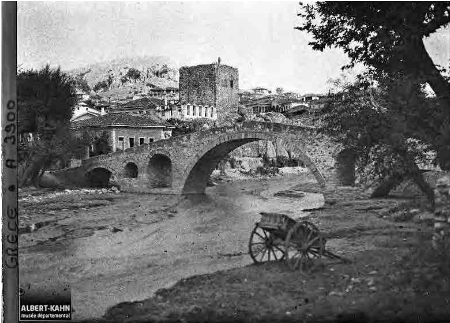
Εικ. 58. Αυτοχρωματική φωτογραφία της αποστολής του Ιδρύματος “Archives de la Planète” (Αρχεία του Πλανήτη) με κωδικό (A 3900) με ημερομηνία λήψης την 17η Σεπτεμβρίου 1913 με το τρίτοξο πέτρινο γεφύρι (γέφυρα του Κρουσοβίτη ή γέφυρα του Σταυρού) που ήταν χτισμένο κατά την ηπειρώτικη τυπολογία. Διακρίνεται ακριβώς πίσω από τη γέφυρα ο πύργος του Ανδρόνικου Γ', περιστοιχιζόμενος από κατοικίες, και ακόμη πιο βόρεια η συνολική ανάπτυξη των οικιών στο λοφώδες Βαρόσι (Πηγή: http://collections.albert-kahn.hauts-de-seine.fr/ ).
