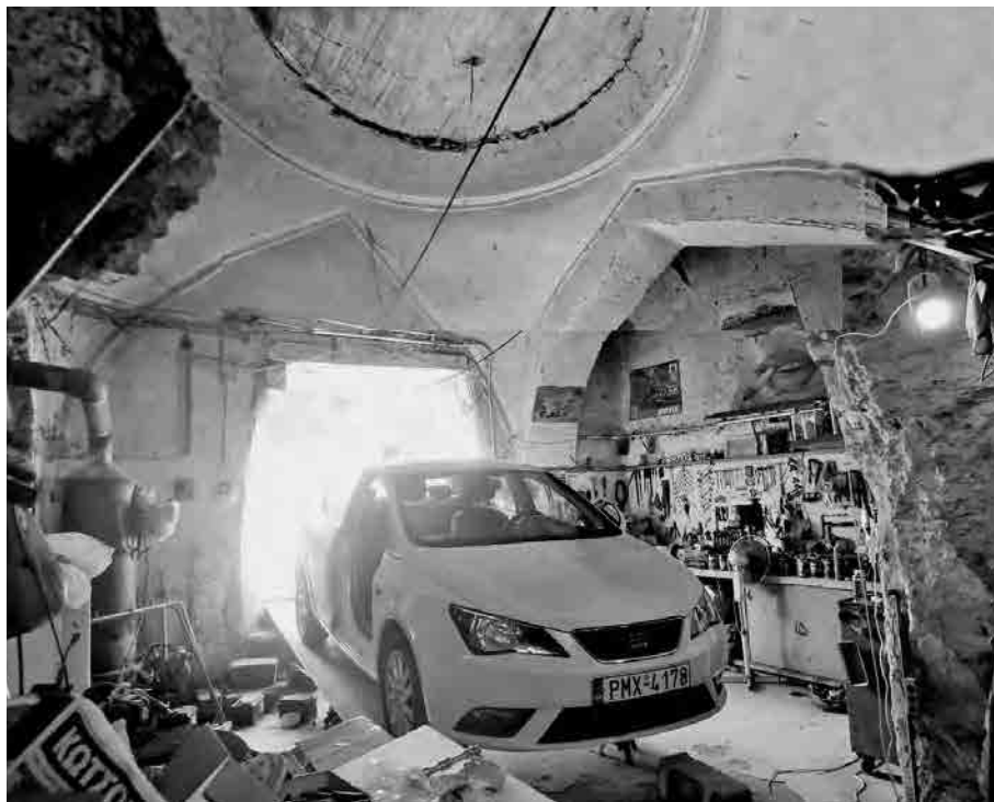
Εικ. 51. Φωτογραφία από τον διπλό χώρο του χλιαρού τμήματος ( soşukluk ), κεντρικό και μικρότερο παράπλευρο, στο ανδρικό (δυτικό) τμήμα του χαμάμ. Διακρίνεται ο κατεστραμμένος θόλος του κεντρικού τμήματος και τα οξυκόρυφα τόξα, όπου το δεξί οξυκόρυφο τοξωτό άνοιγμα ένωσε το κεντρικό χλιαρό τμήμα με τον μακρόστενο παράπλευρο χώρο (διακρίνεται ο τοίχος του στο βάθος όπου είναι ανηρτημένα τα εργαλεία του συνεργείου) που στεγαζόταν από τρεις μικρούς θόλους σε παράταξη. Το αριστερό άνοιγμα δεν υπήρχε και διανοίχθηκε εκ των υστέρων για τη λειτουργία (είσοδο) του συνεργείου. Αντιστοιχούσε σε τοίχο ανάμεσα στο χώρο του κεντρικού χλιαρού τμήματος και στο χώρο της Εισόδου/Αποδυτηρίων ( camekân ), που είναι πια κατεστραμμένοι. - (φωτ.τ.σ., 2017).
