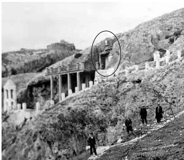
Εικ. 60. Φωτογραφία εποχής από την περίοδο της ανέγερσης του ναού του Αγ. Δημητρίου, Αγ. Κηρύκου και Ιουλίττας και Αγίας Ζώνης (1939), όπου διακρίνονται οι κολώνες από οπλισμένο σκυρόδεμα για τη δημιουργία της εξέδρας, όπου στηρίχθηκε ο ναός. Στο βάθος της εξέδρας, προς τα δεξιά, διακρίνεται καθαρά ο λαξευμένος στον βράχο μακεδονικός τάφος (σε κύκλο), πριν αυτός κα-
