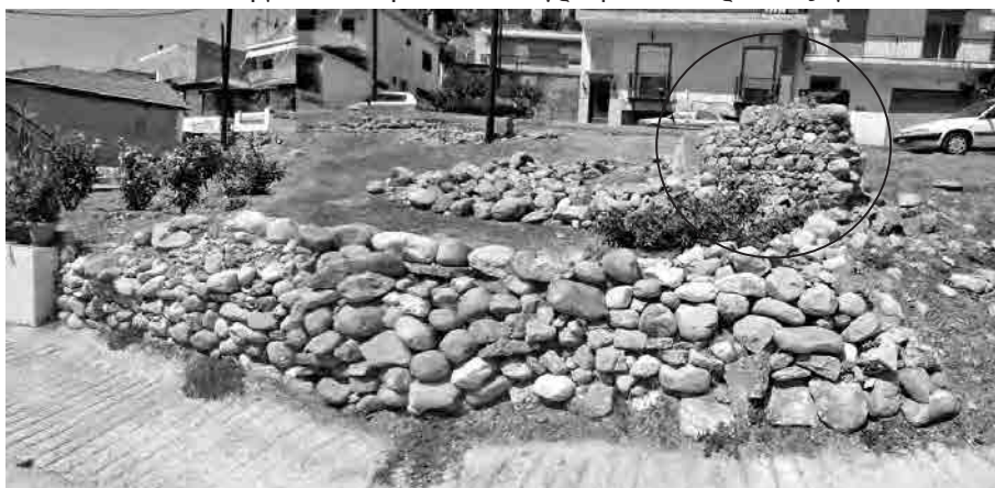
Εικ. 30. Απομεινάρια κτίσματος της οθωμανικής περιόδου, όπου παραμένει στη θέση του τμήμα τοίχου (επισημαίνεται με κύκλο) στη βόρεια περιοχή που Βαρουσιού, σε μια γενικά αδόμητη περιοχή, απέναντι από την Μητρόπολη του Σιδηροκάστρου, σε αντίθεση με την υπόλοιπη πυκνή οικιστική δομή στο Βαρόσι. Η περιοχή συμπίπτει με την περιοχή χωροθέτησης ενός τζαμιού στο χάρτη του Chabert. Ελέγχοντας την λοξή κατεύθυνση του τοίχου που συμπίπτει σε γενικές γραμμές με την κατεύθυνση των τζαμιών θα μπορούσαμε να θεωρήσουμε ότι ανήκει στο χαρτογραφημένο από τον Chabert μνημείο (φωτ.τ.σ., 2017).
