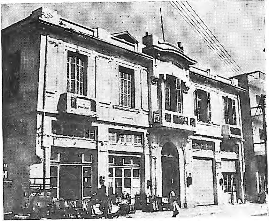
Εικ. 8. Κοινοτικό κατάστημα 'Ελανομής.
