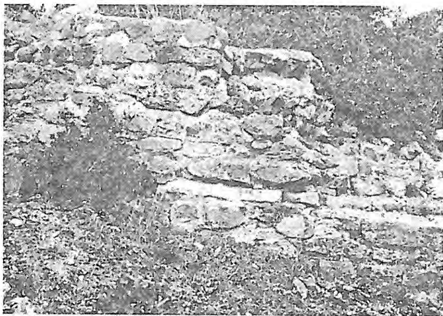
Εικόνα 11. Το δυτικό άκροβαθρο της ύδατογέφυρας.
