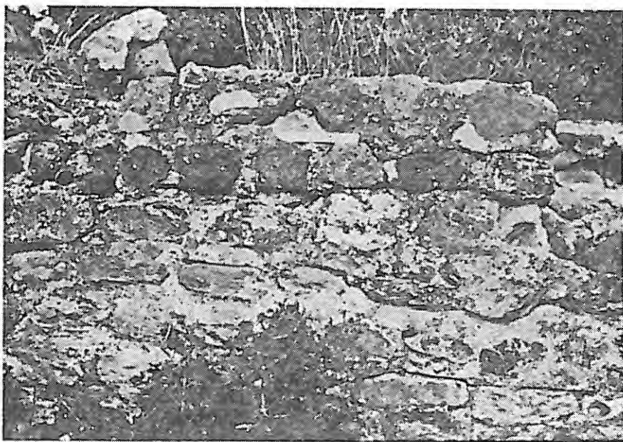
Εικόνα 13. Λεπτομέρεια της τοιχοδομίας του δυτικού ακροβάθρου της Ύδατογέφυρας.
