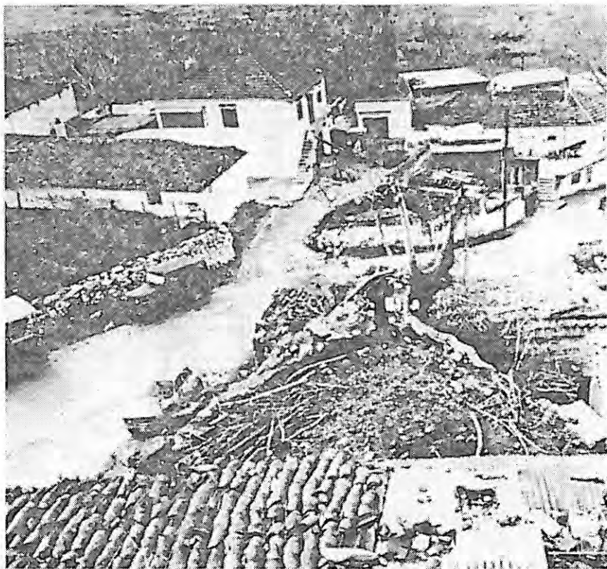
Εικόνα 22. Η υδατοδεξαμενή του μύλου 2 κάτω από τον Πύργο, φωτογραφημένη από τον υδατόπυργο του μύλου 1 (φωτογραφία Πλ. Θεοχαρίδου).
